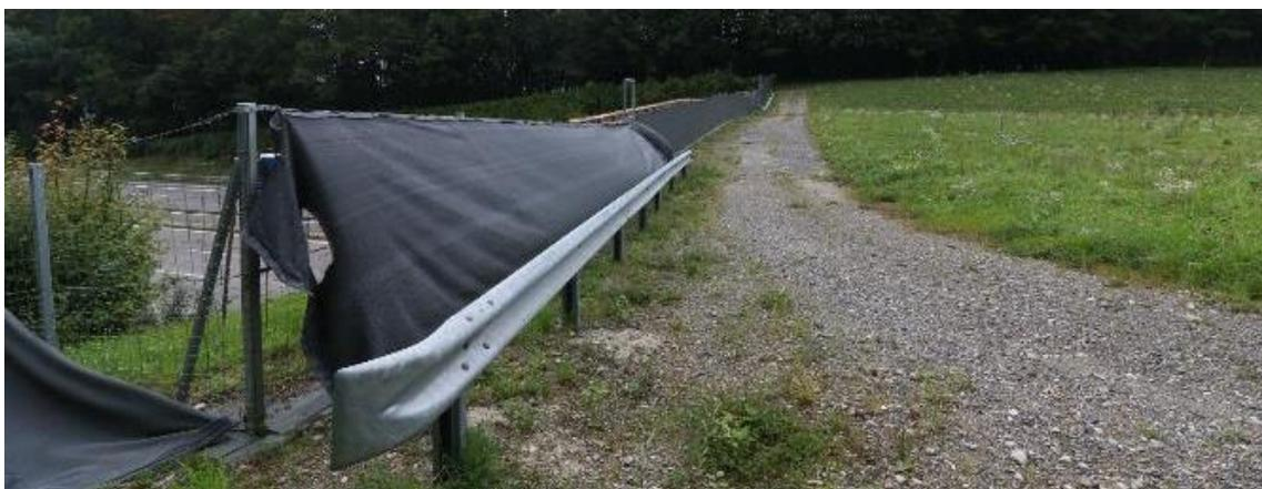
Abbildung 128: Beschädigung des Sichtschutzes
